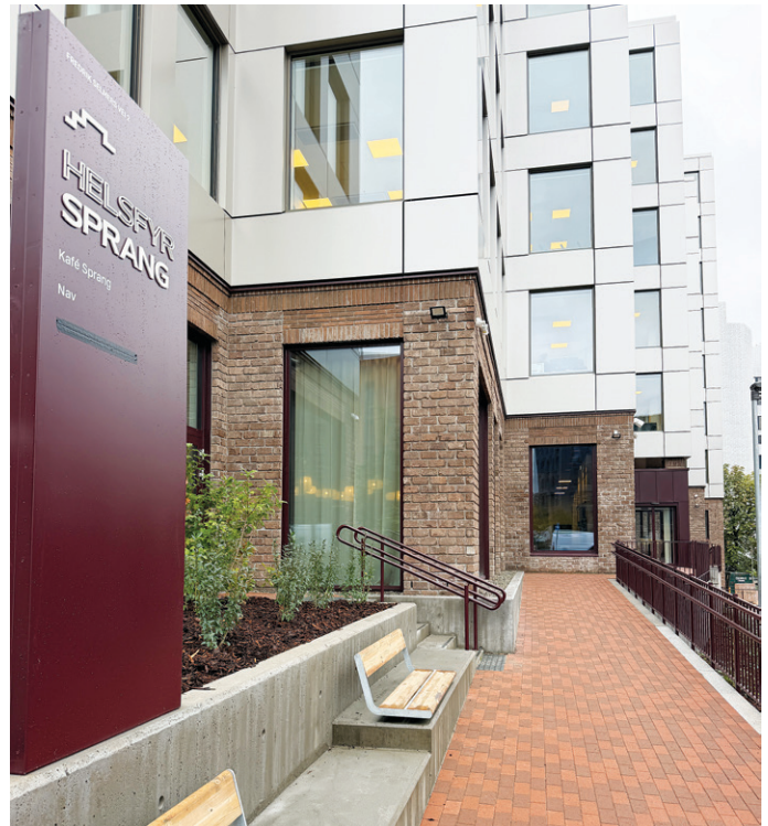
Deler av bygget er kledd med ombruks-tegl fra bygget som tidligere sto på tomten.
