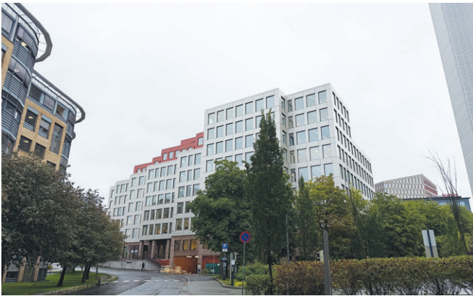
Nybygget har en påhengsfasade i aluminium.
